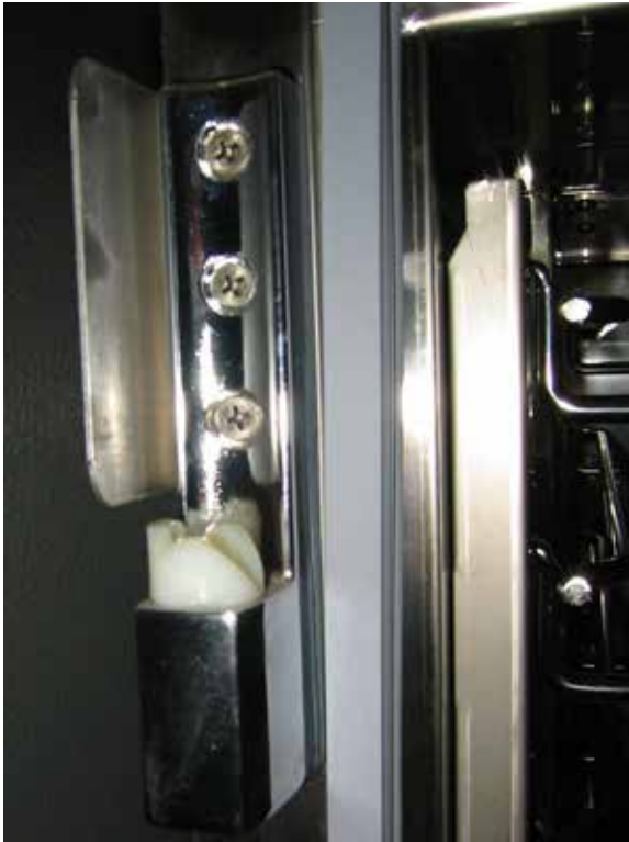
لاحظ وضعية القطعة البلاستيكية المنحنية على الكامة بعد تدويرها بزاوية 180 درجة.
